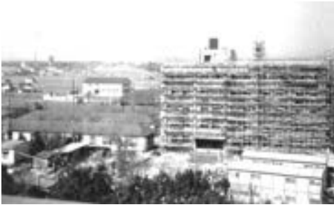
建設中の新庁舎
